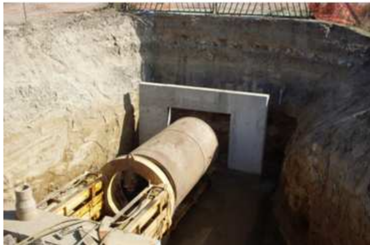
Vista de los muros de reacción efectuados.
