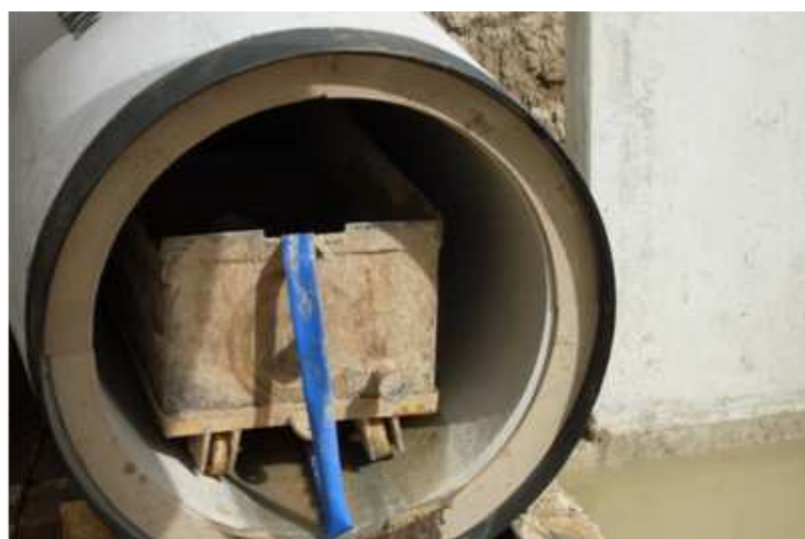
Vista de la vagoneta saliendo del interior de la tubería.
