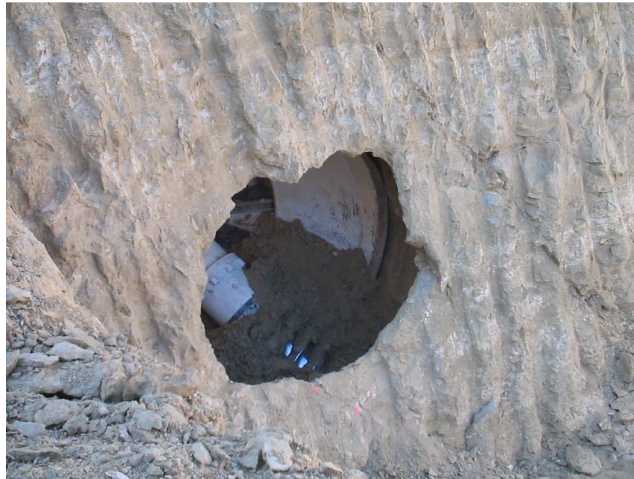
Vista de la rozadora saliendo por el pozo de salida.
